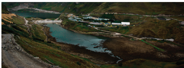
Se ha completado la construcción del reservorio de Chailhuagón.
